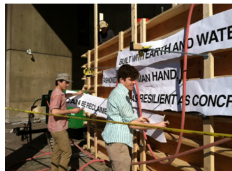
78. MudWorks, κατασκευή καλουπιών.
