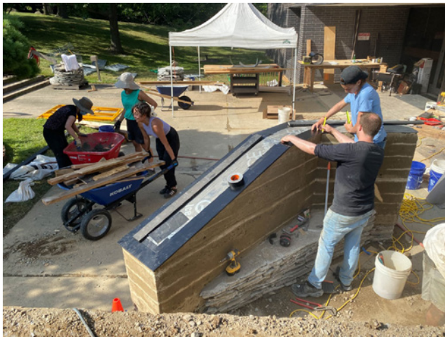
109. Κατασκευή με αχυροπηλό (πάνω), κατασκευή με πατητή γη (κάτω), Natural Materials Lab.
