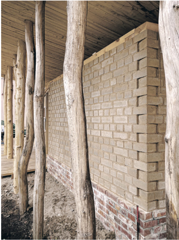
86. Παραγωγή άψητων πλίνθων από εκσκαφές εργοταξίων. Οι πλιθιές έγιναν στα πλαίσια της εργασίας των Micha Kretschmann και Christian Gäth, απόφοιτων της TU Berlin και του μεταπτυχιακού προγράμματος του Natural Building Lab. Η έρευνα τους προτάθηκε για το Γερμανικό Κρατικό Βραβείο Οικολογικού Σχεδιασμού (Bundespreis Ecodesign). Σε συνεργασία με το Bauhaus Erde, οι πλίνθοι αυτοί χρησιμοποιήθηκαν για πρώτη φορά το καλοκαίρι του 2024 σε ένα πιλοτικό κτίσμα στο κέντρο της Potsdam.
