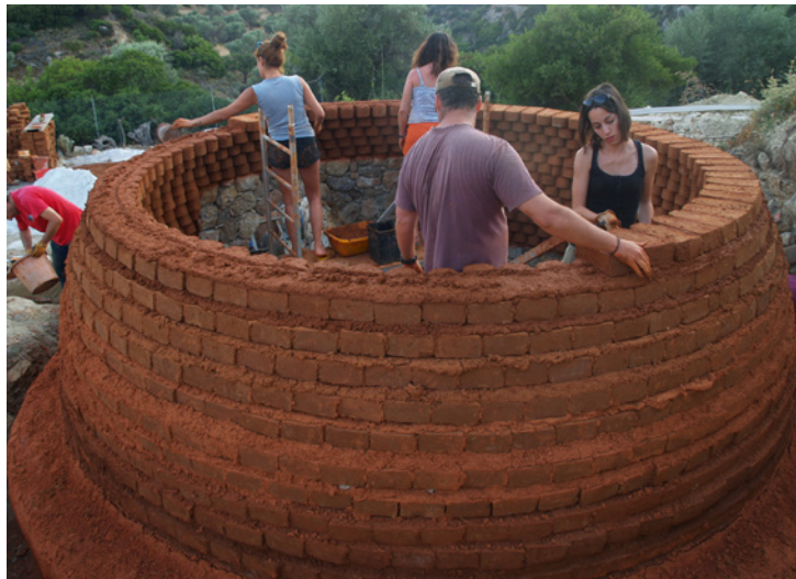
95. Θολωτή κατασκευή από ωμόπλινθους, κατά τη διάρκεια κατασκευής. 96. Ανέγερση θόλου και συνεργασία στην κατασκευή.
