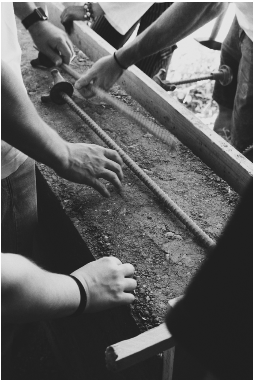
72. Ξεκαλούπωμα του rammed earth, Full Immersion Nella Terra, 2025.
