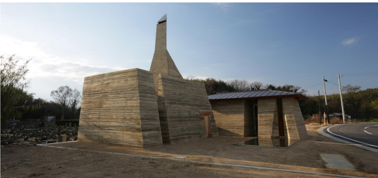
εικ.6.16. Εξωτερική άποψη του κτίσματος Zenkonyu x Tamping Earth. (ανακτήθηκε από: https://www.archdaily.com/506198/zenkonyu-tamping-earth-tadashi-saito-atelier-nave στις 08/04/22).
