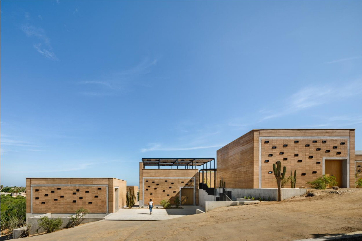
εικ.6.10. Πρόσοψη του Casa Ballena Art Center. (ανακτήθηκε από: https://www.archdaily.com/942459/casa-ballena-art-center-rima-arquitectura?ad_source=search&ad_medium=projects_tab στις 06/04/22).
