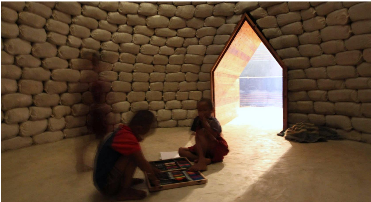
εικ.1.15. Το εσωτερικό μιας μικρής κατασκευής από γαιοσάκους. (ανακτήθηκε από: https://architizer.com/blog/inspiration/industry/school-floating-in-the-sky/ στις 13/11/21).
