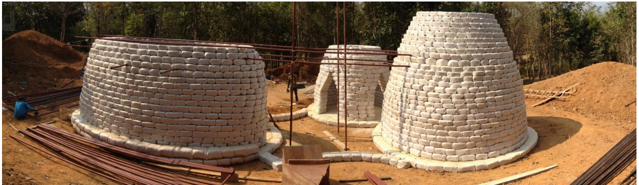
εικ.1.18. Το Floating in the Sky School for Orphans κατά την κατασκευή. (ανακτήθηκε από: https://www.archdaily.com/630188/floating-in-the-sky-school-for-orphans-kikumawatanabe?ad_source=search&ad_medium=projects_tab στις 06/05/22).
