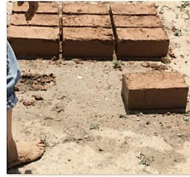
Φυσική ξήρανση των ωμοπλινθων
