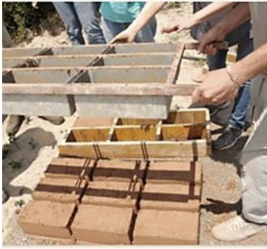
Αφαίρεση των πλαισίων στήριξης (καλουπιών)
