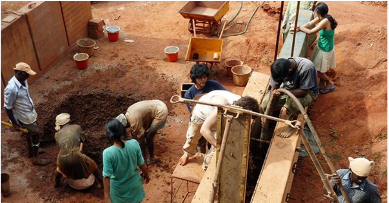
εικ.1.25. Η διαδικασία κατασκευής δομικού στοιχείου από ρευστή γη. (ανακτήθηκε από: http://www.earth-auroville.com/poured_earth_research_en.php στις 06/05/22).
