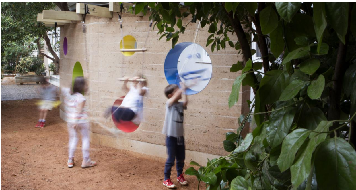
εικ.6.25. Ο τοίχος από rammed earth στο Παιχνιδαγωγείο Δημοτικό Σχολείο, στο Νέο Ψυχικό. (ανακτήθηκε από: https://www.subu.gr/selected/rammed-earth-playwall/ στις 06/04/22).
