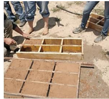
Τελική διαμόρφωση επιφάνειας ωμοπλινθων
