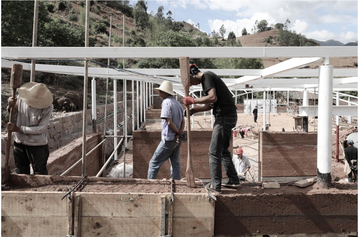
εικ.1.21. Η διαδικασία συμπίεσης του χώματος για το rammed earth. (ανακτήθηκε από: https://www.archdaily.com/968229/local-techniques-in-big-cities-beyond-earth-and-bamboo?ad_source=search&ad_medium=projects_tab&ad_source=search&ad_medium=search_result_all στις 13/11/21).
