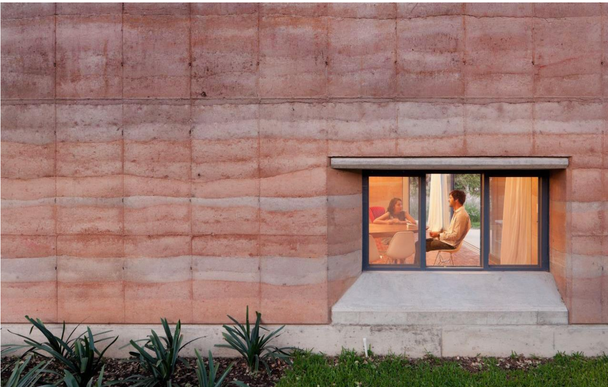
εικ.1.20. Το τελικό αποτέλεσμα της τοιχοποιίας από rammed earth. (ανακτήθηκε από: https://www.archdaily.com/894341/rammed-earth-construction-15-exemplary-projects?ad_source=search&ad_medium=projects_tab&ad_source=search&ad_medium=search_result_all στις 13/11/21).
