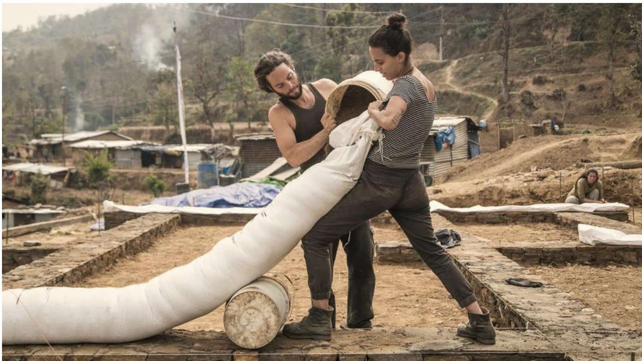
εικ.1.16. Στιγμιότυπο από τη διαδικασία γεμίσματος των γαιοσάκων. (ανακτήθηκε από: https://architizer.com/blog/inspiration/industry/school-floating-in-the-sky/ στις 13/11/21).
