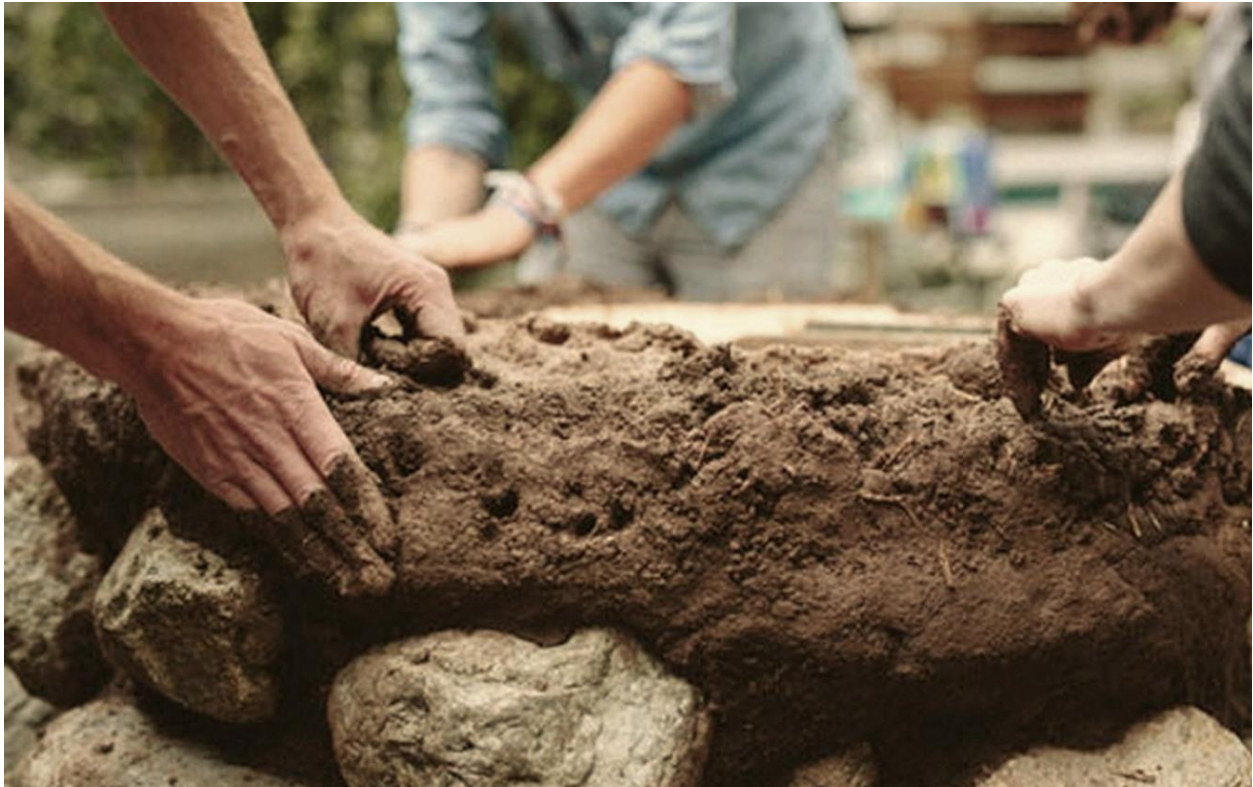
εικ.1.11. Η τοποθέτηση των σβόλων πάνω στα πέτρινα θεμέλια. (ανακτήθηκε από: https://www.re-thinkingthefuture.com/rtf-fresh-perspectives/a1704-10-construction-techniques-used-in-earth-architecture/ στις 12/11/21).
