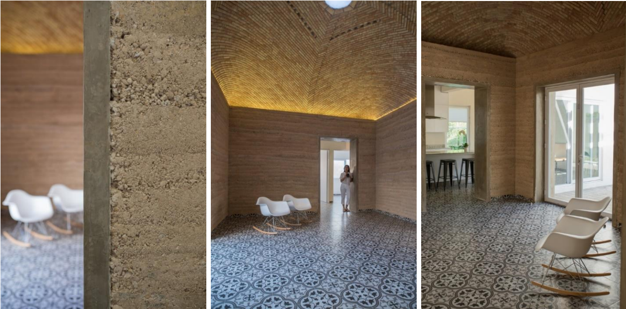
εικ.6.15. Εσωτερικές απόψεις από το σταυροθόλιο του Earth House και τους τοίχους από rammed earth. (ανακτήθηκε από: https://www.archdaily.com/877159/earth-house-earthlab-studio?ad_source=search&ad_medium=projects_tab στις 08/04/22).
