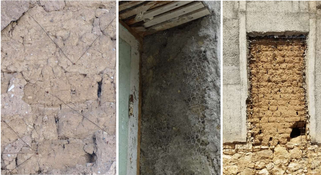
Εικόνες 5.2, 5.3 & 5.4 Μεταλλικό πλέγμα για την εφαρμογή στρώσης επιχρίσματος, αυτοσχέδιο (αριστερά), κοτετσόσυρμα (κέντρο) και εφαρμογή guinite (δεξιά).
