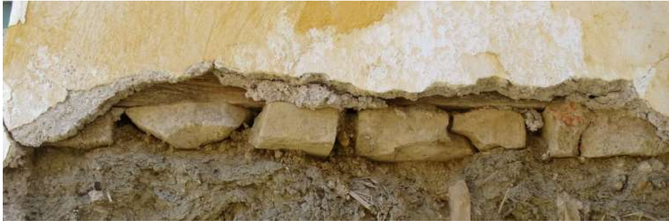
Εικόνα 3.23 Έδραση ξυλοδεσιάς σε σειρά λίθων.
