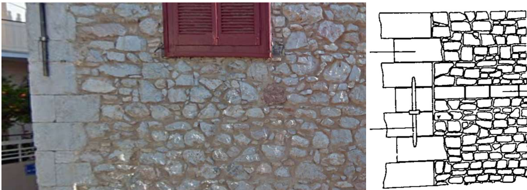
Εικόνες 6.12&6.13: Αριστερά: δείγμα ανεπίχριστης λιθοδομής σε γειτονικό κτίριο. Δεξιά: τμήμα σχεδίου λεπτομέρειας όψης σε κατοικία στο Γαλαξίδι 106 .
