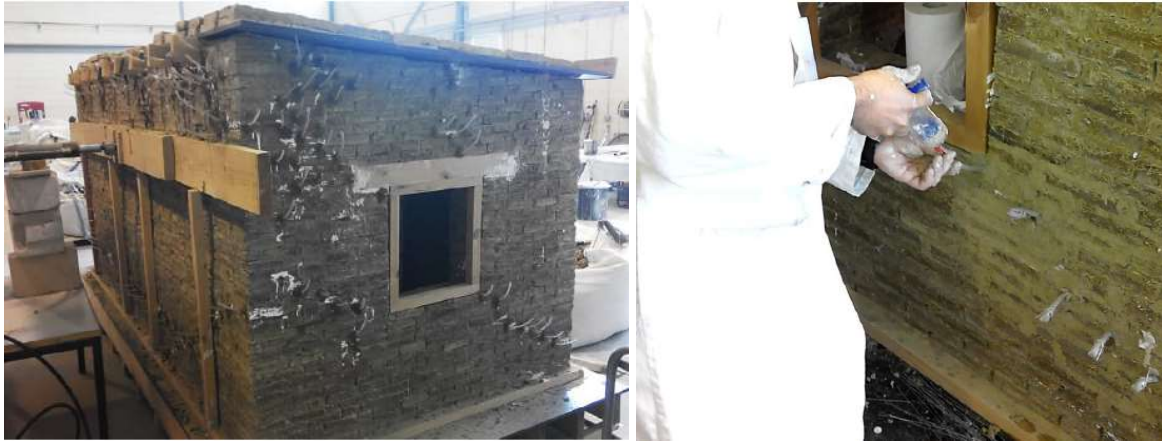
Εικόνες 5.9 & 5.10 Αριστερά: Εφαρμογή ενεμάτων στα σημεία που έχουν υποστεί βλάβες. Δεξιά: Τοποθέτηση σωληνίσκων κατά μήκος της ρωγμής 84 .
