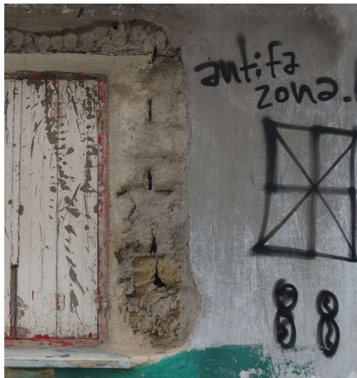
Εικόνα 5.1 Στρώση τσιμεντοκονιάματος επί ωμοπλινθοδομής.
