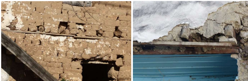
Εικόνα 3.25 & 3.26 Δοκοί πατωμάτων με έδραση σε όλο το πάχος του τοίχου.
