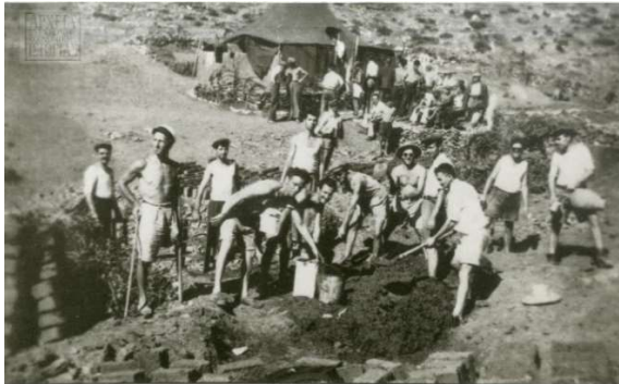
Εικόνες 1.32 & 1.33 Εξόριστοι στον Αη Στράτη (δεκαετία 1950) κατασκευάζουν πλίνθους, πέραν των σκαπτικών εργαλείων διακρίνεται καλούπι τεσσάρων θέσεων. 43
