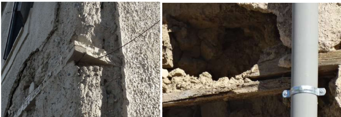
Εικόνα 3.21 & 3.22 Τρόποι σύνδεσης ξύλινων στοιχείων. Αριστερά: μισοχαρακτή σύνδεση σε γωνία. Δεξιά: απλή σύνδεση με ένα καρφί.
