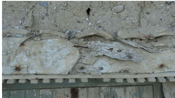
Εικόνα 3.24 Προστασία πρεκιού με σειρά απο κεραμίδια.
