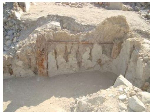
Εικόνα 1.12 & 1.13. Αριστερά: Δομική μονάδα μικρού βάρους από άχυρο και λάσπη. Δεξιά: Ξύλινος σκελετός σε χωμάτινο τοίχο στην κορυφή της πυραμίδας του Caral, Περού. 26
