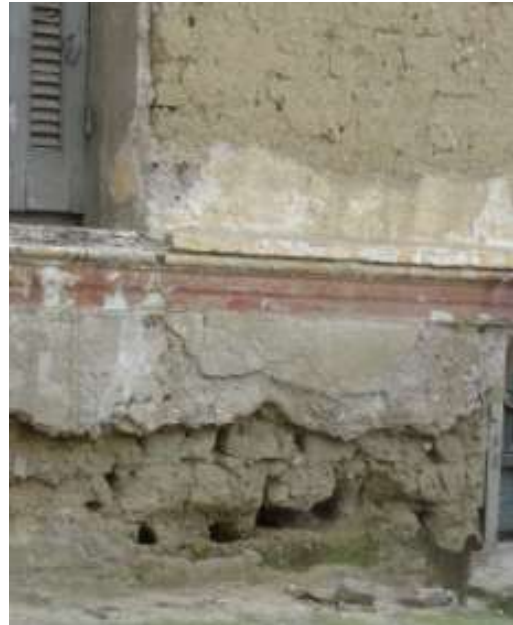
Εικόνες 4.3 & 4.4 Δεξιά: Σχέδιο τομής πλίνθινου δομήματος 73 . Σημειώνεται ο κύκλος του νερού ως κύρια αιτία διάβρωσης. Αριστερά: Απομείωση της διατομής στην βάση του τοίχου, απουσία λίθινης βάσης, λόγω ανερχόμενης υγρασίας.
