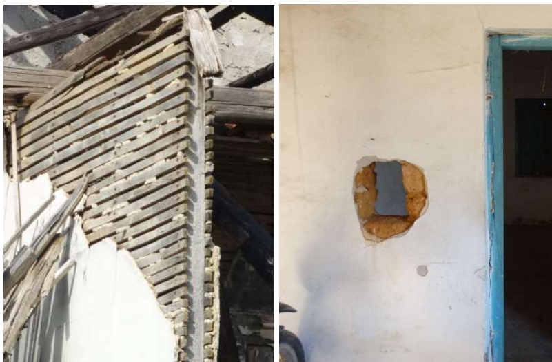
Εικόνες 3.27 & 3.28 Αριστερά: Μπαγδατί στην Πάτρα, δεξιά: εσωτερικός πλιθινός δρομικός τοίχος στα Χανιά.
