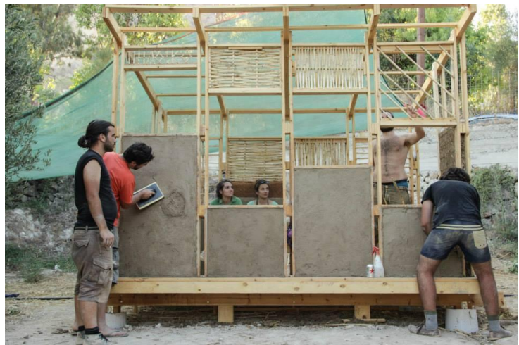
"Εικόνα 3: Εφαρμογή πηλοκοκονιαμάτων στη πειραματική κατασκευή."
