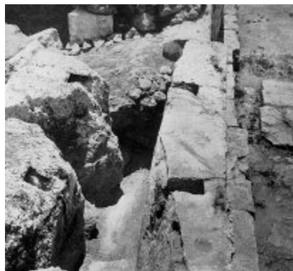
Figure 15b. Murs doubles reliés par des poutres de bois, (Photo A. Evans, 1921).
