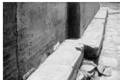
Figure 10b. Semelle de fondation filante au palais de Phaistos (photo L. Pernier, 1935).
