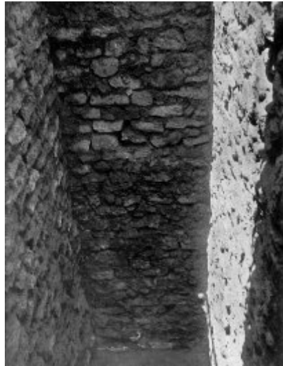
Figure 11b. Fondation en puits au palais de Knossos (photo A. Evans, 1928).
